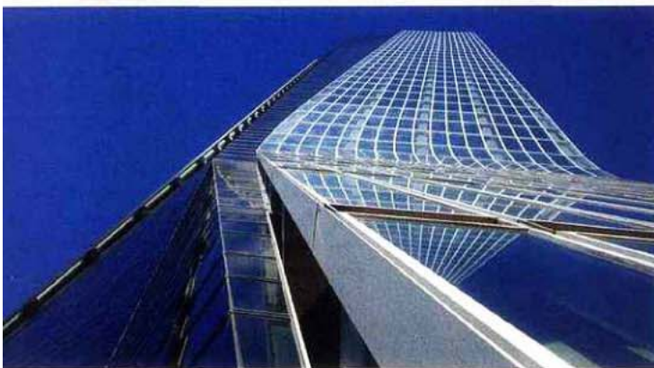
Voiles. Plus de 6 000 vitrages courbes occupent une surface de cinq terrains de foot.
