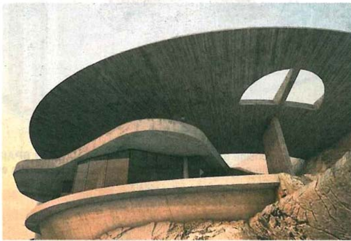
La Casa Arango, encaramada en las colinas de la localidad mexicana durante su construcción, en el año 1973. / Julius Schulman
