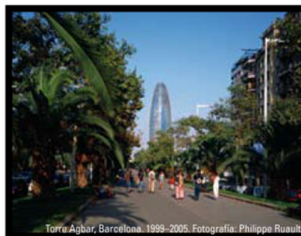
Torre Agbar, Barcelona. 1999-2005. Fotografía: Philippe Ruault
