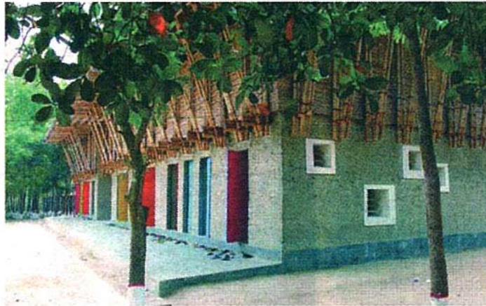
Une école auto-construite au Bangladesh.
