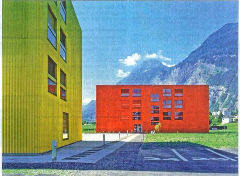
Bonnard et Woeffray. Une construction réalisée à Saint-Maurice, en Valais, entre 2000 et 2003. (HANNES HENZ)
