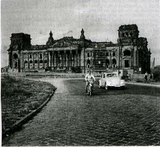
Leerstelle. Die Reichstagsruine im Sommer 1958. Zu dieser Zeit begannen die Renovierungsarbeiten. Bis 1971 wurde das Gebäude wieder aufgebaut. Foto: Josef Heinrich Darchinger/Promo
