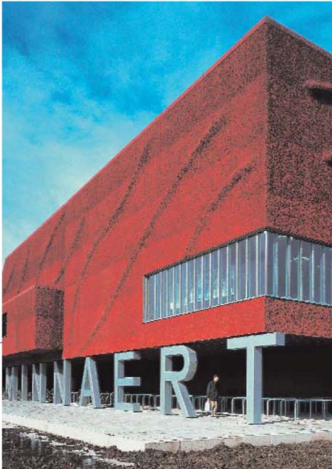
En la imagen, el edificio Minnaert, en Utrecht, de los arquitectos holandeses Willem Jan Neutelings (1959) y Michiel Riedijk (1964).
